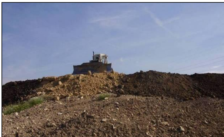
Figure 7 : Mise en remblais des déchets (exemple ISDI de Saint-Witz)
