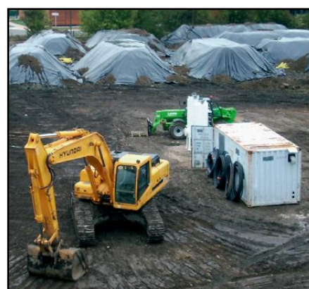
Chantier de dépollution par biotraitement
