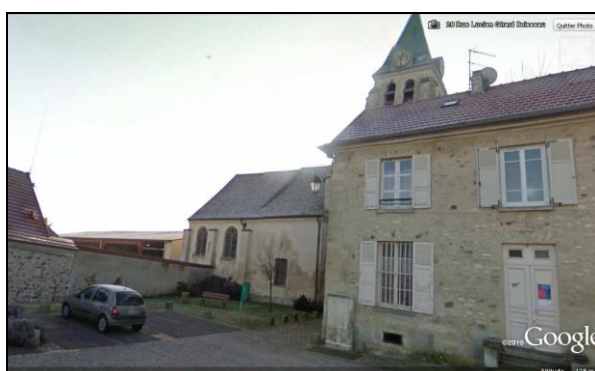
Figure 29 : Vue vers le sud-est : site non visible, en arrière plan de l'église
